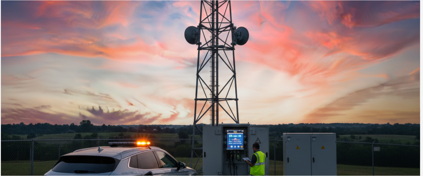
Elektroautos können bei Blackouts Mobilfunkstationen mit Strom versorgen
