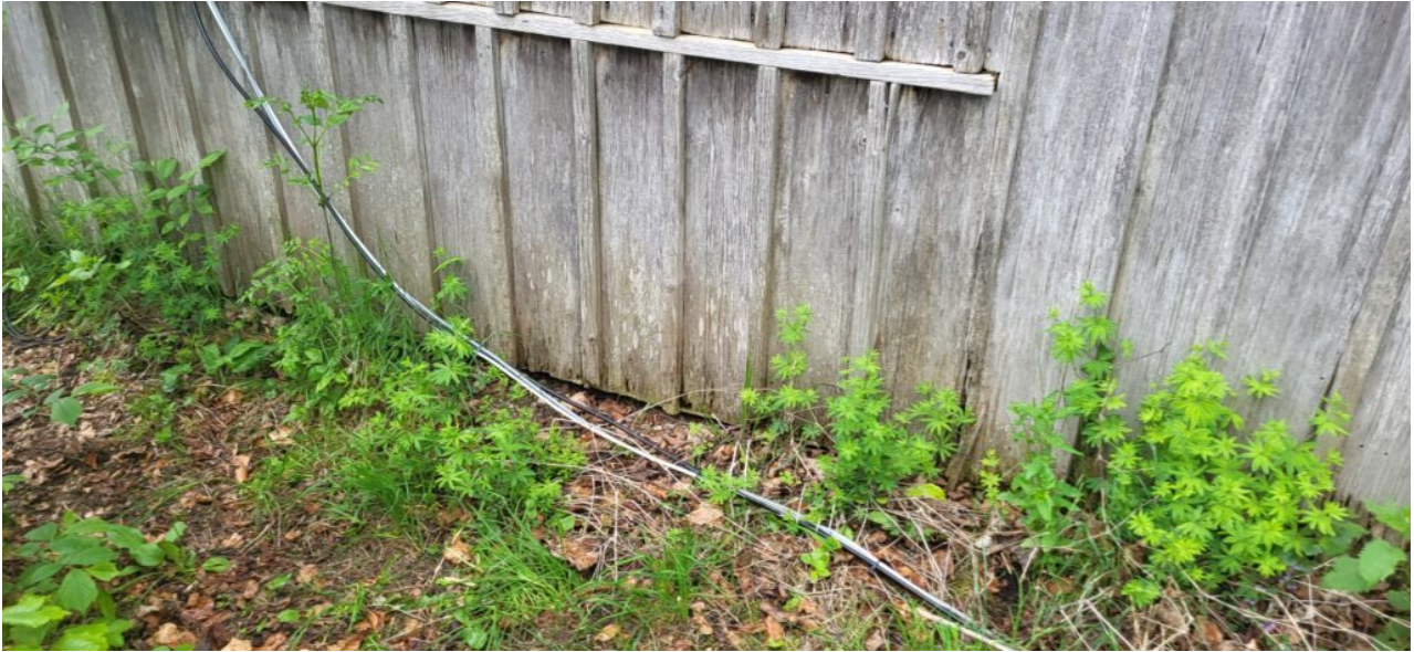
Kabel zur Loop
