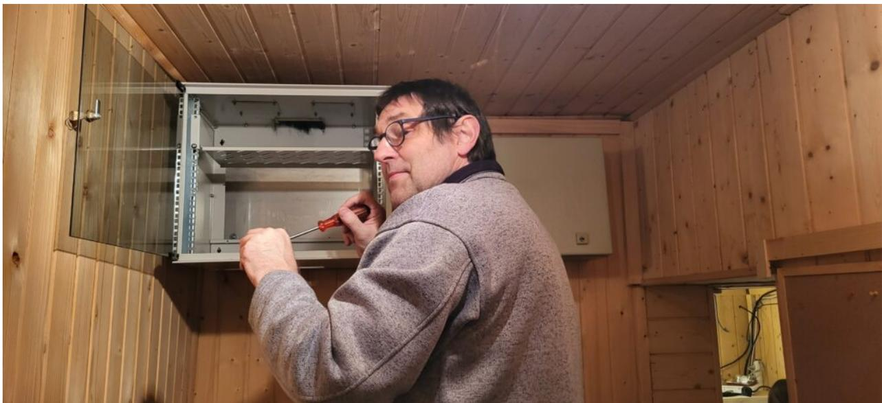
Das Rack für den 70cm Fusion-Repeater wurde im Vorraum an die Wand montiert (vorher stand es unter dem Operateur-Pult), daneben der Schrank für die Notstrom - Akkus. So haben wir beim Pult wieder etwas mehr Beinfreiheit.
